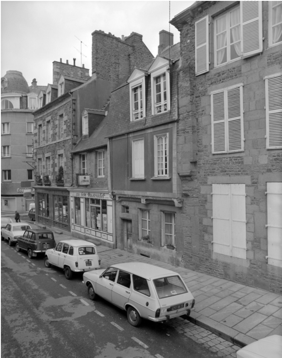
15 rue Chateaubriand, vue générale de la façade ouest.
