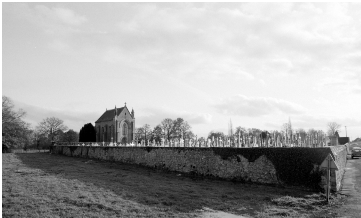
Elévation Nord-Ouest : vue de situation
