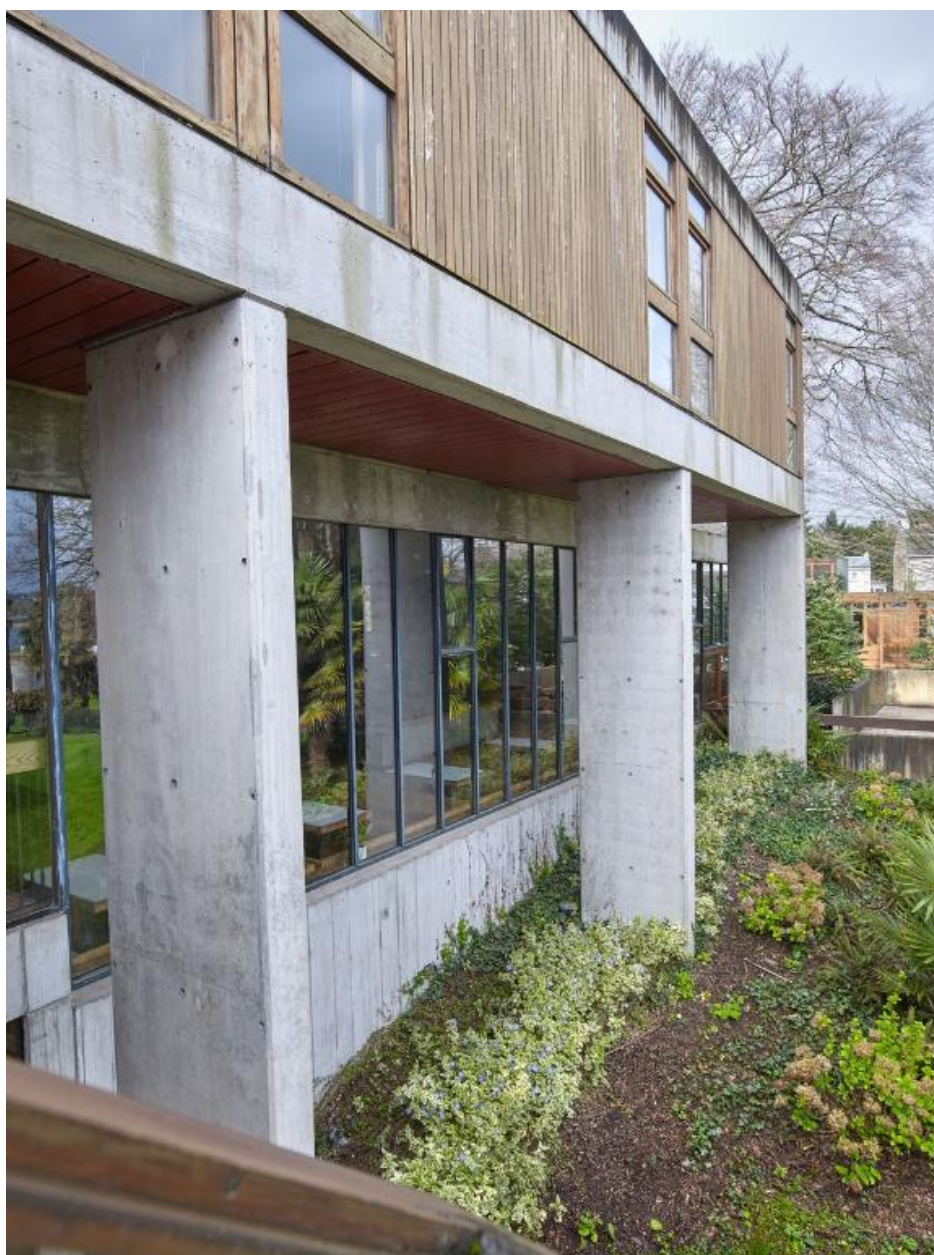
Auberge de jeunesse de Brest : B1, alternance de matériaux (bois, vitre, béton)
