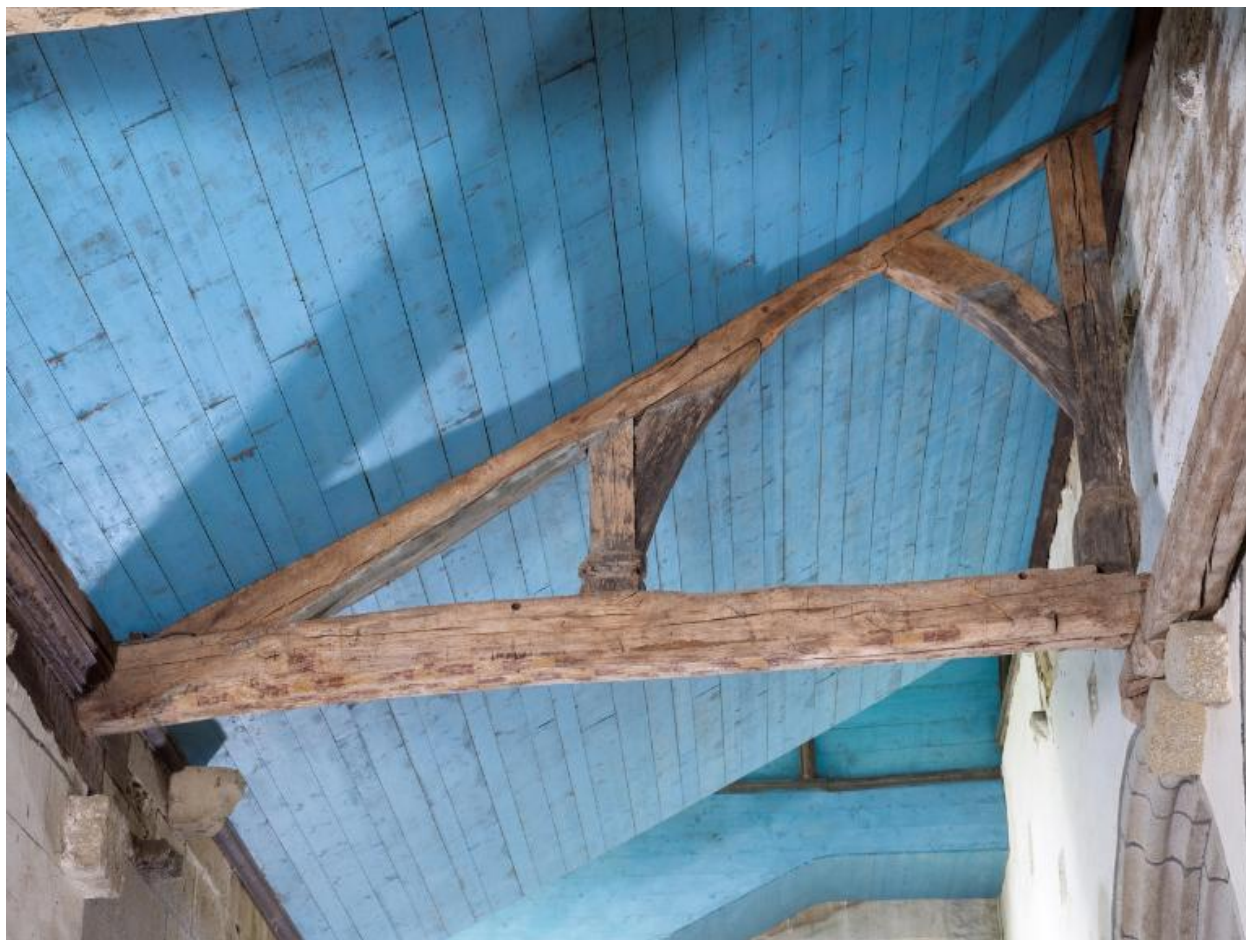
Charpente avec décor peint partie ouest du bas côté sud
