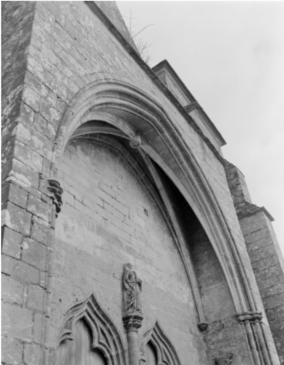
Elévation ouest, voûte du portail
