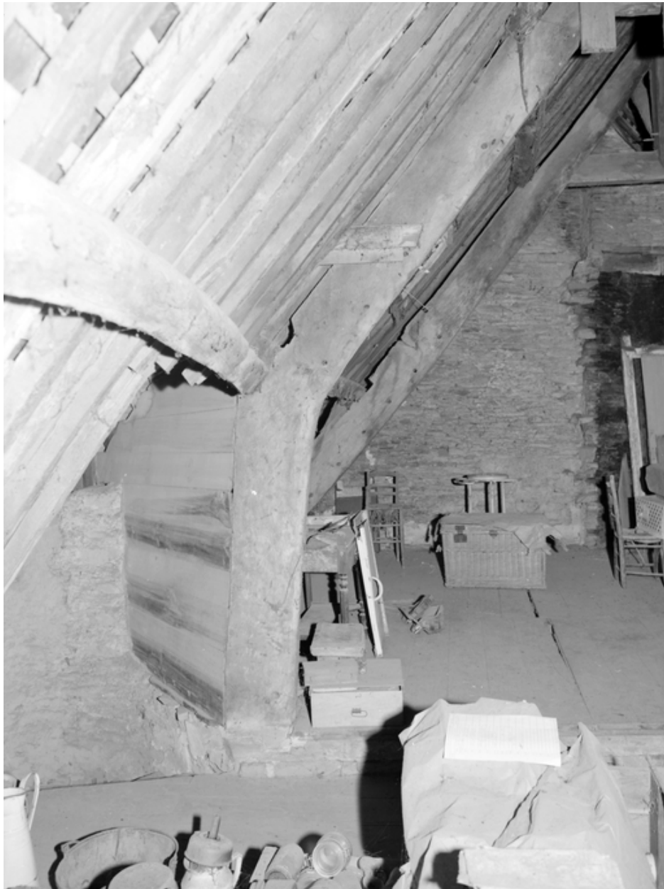
Maison, charpente : une ferme (état en 1984)
