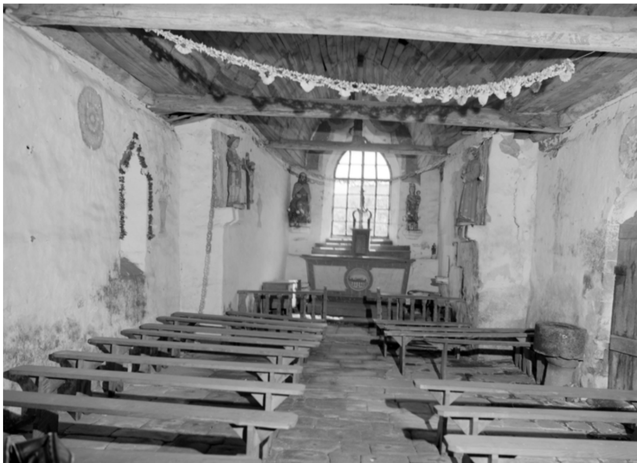
Vue intérieure vers l'est.
