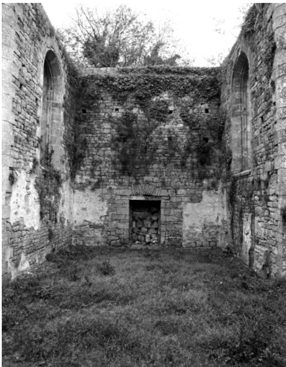
Chapelle, vue intérieure du bras du transept nord
