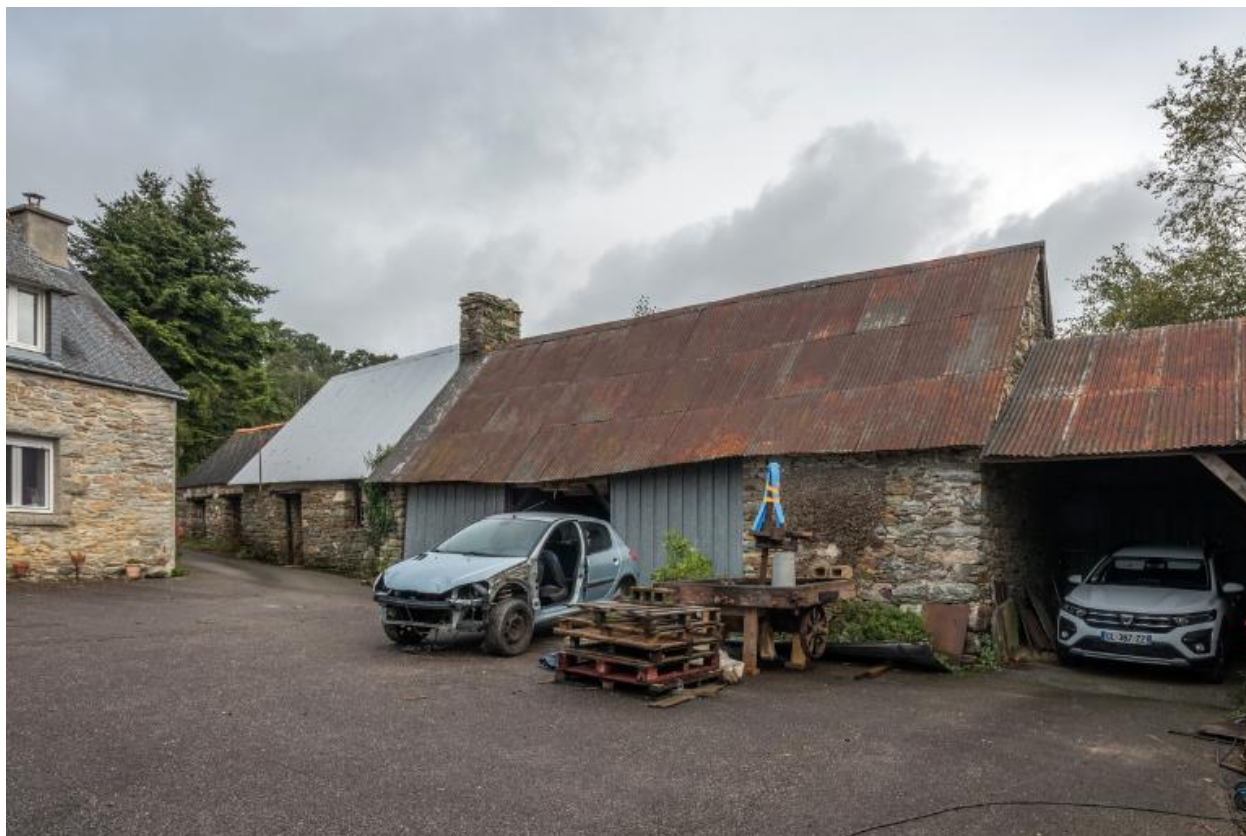
Remise, logis secondaire et étable formant alignement. Vue générale sud-ouest
