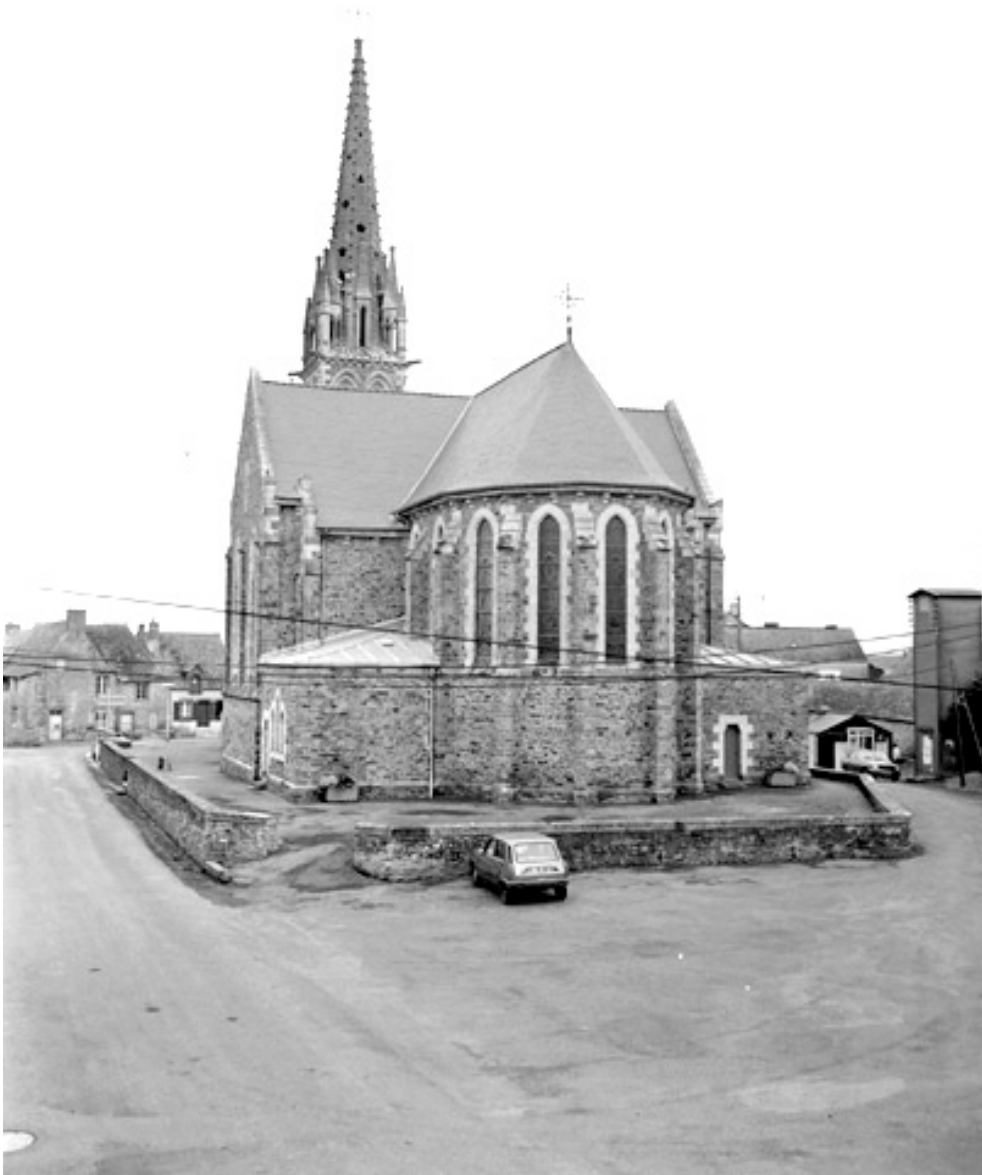
Élévation est : vue générale
