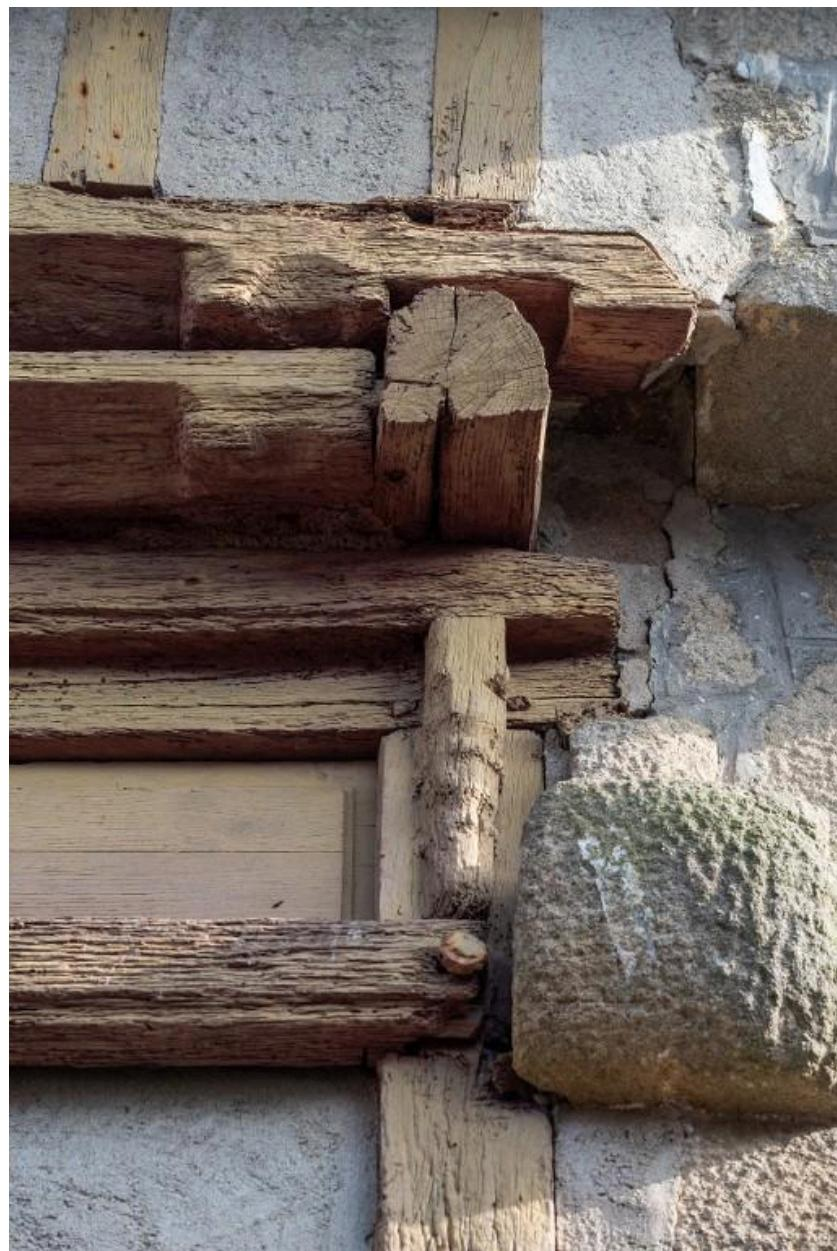
L'assemblage des éléments est ici bien visible : le poteau cornier, appuyé contre le mur, reçoit la sablière de plancher. La solive de rive s'ancre par-dessus et reçoit la sablière de chambrée, par enfourchement.
