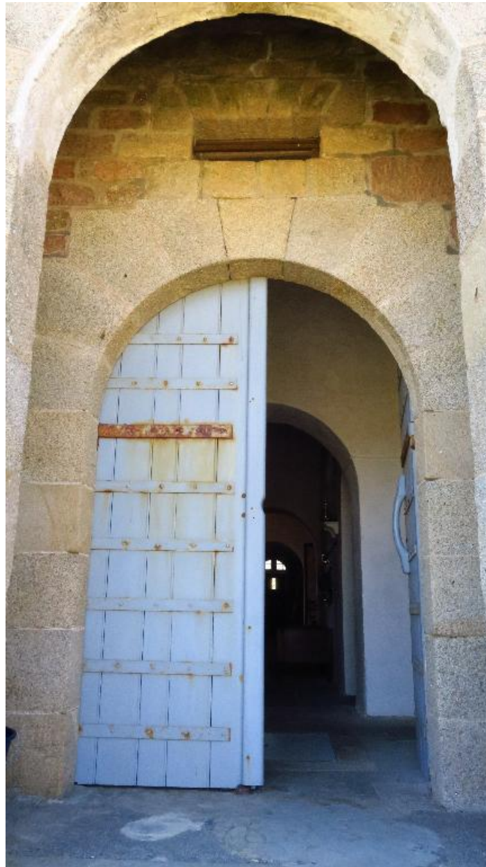
Île-d'Houat, batterie du Béniguet, corps de garde crénelé, porte.
