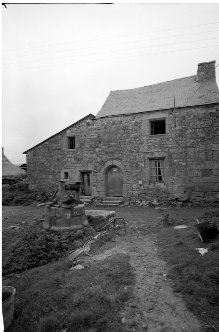
Vue générale de la façade sud
