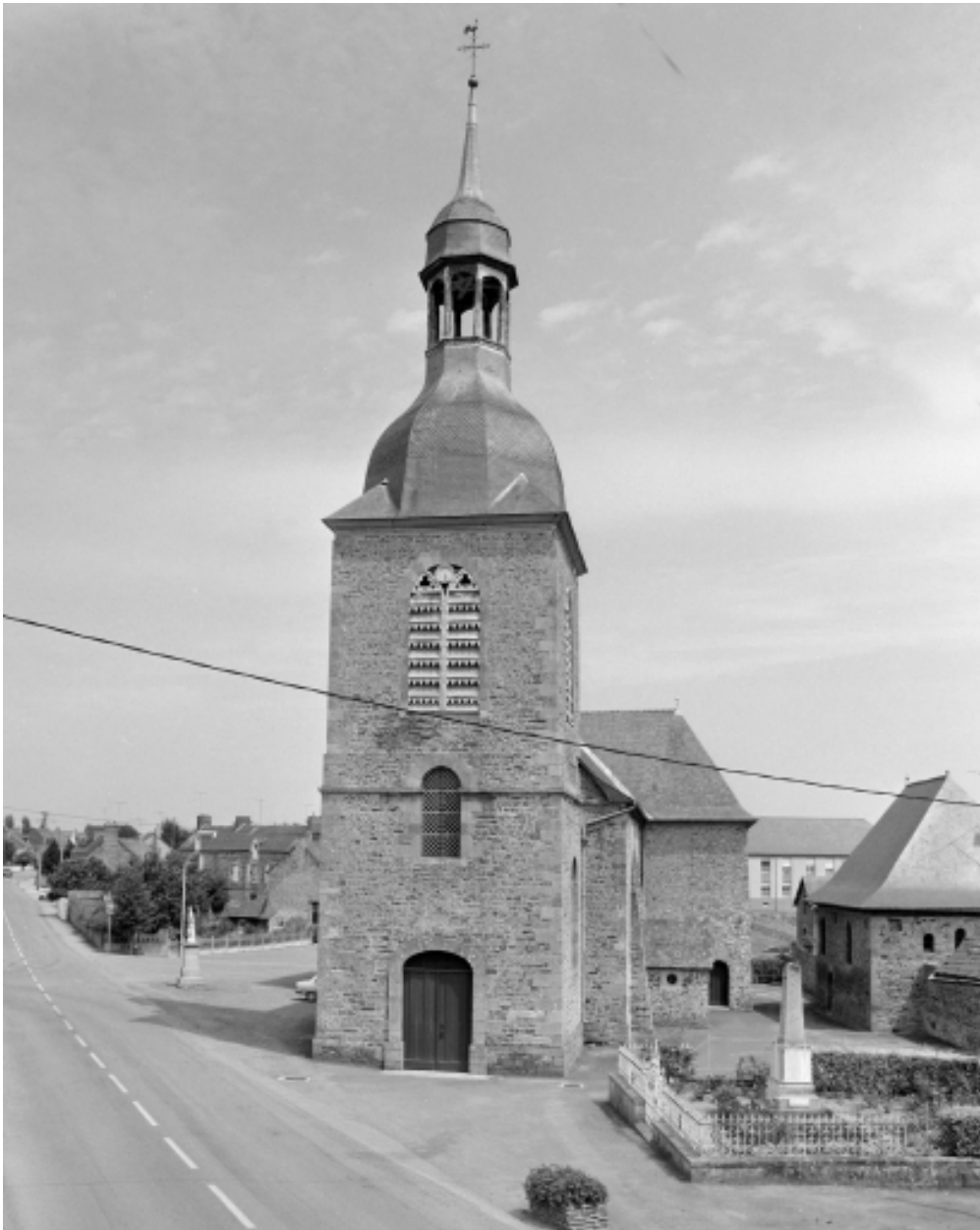
Elévation ouest : vue générale
