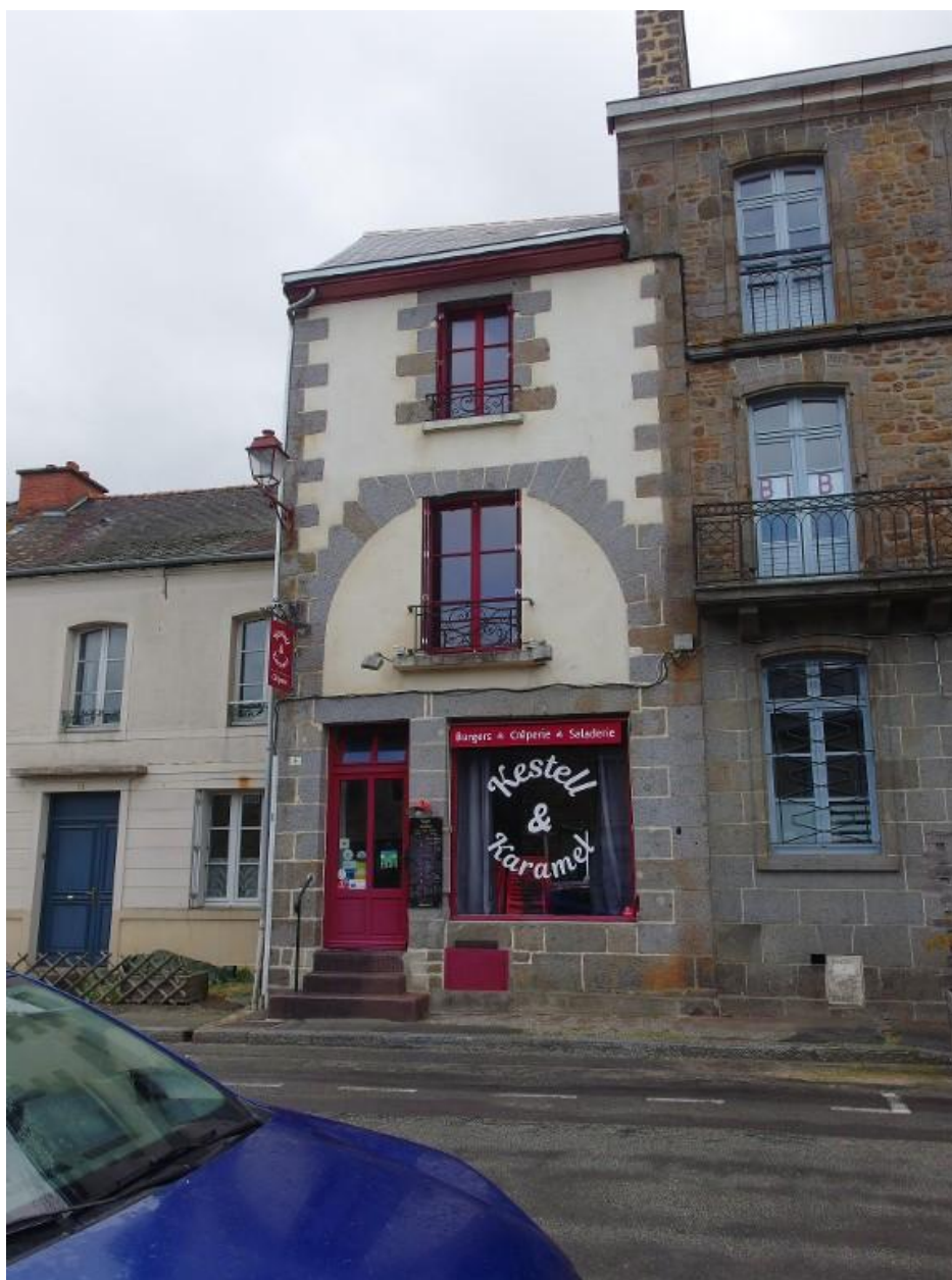
Vue de la façade ouest
