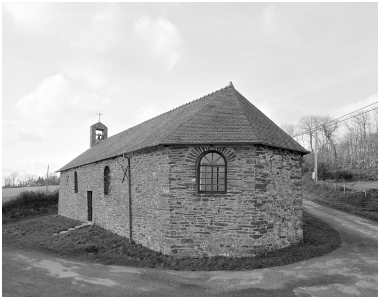
Vue générale est
