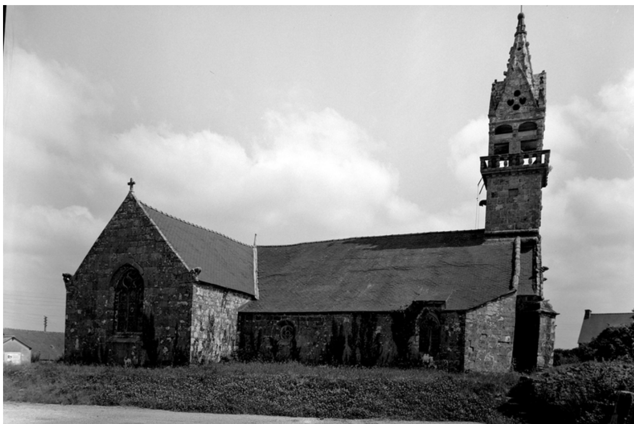
Elévation nord : vue prise du nord ouest
