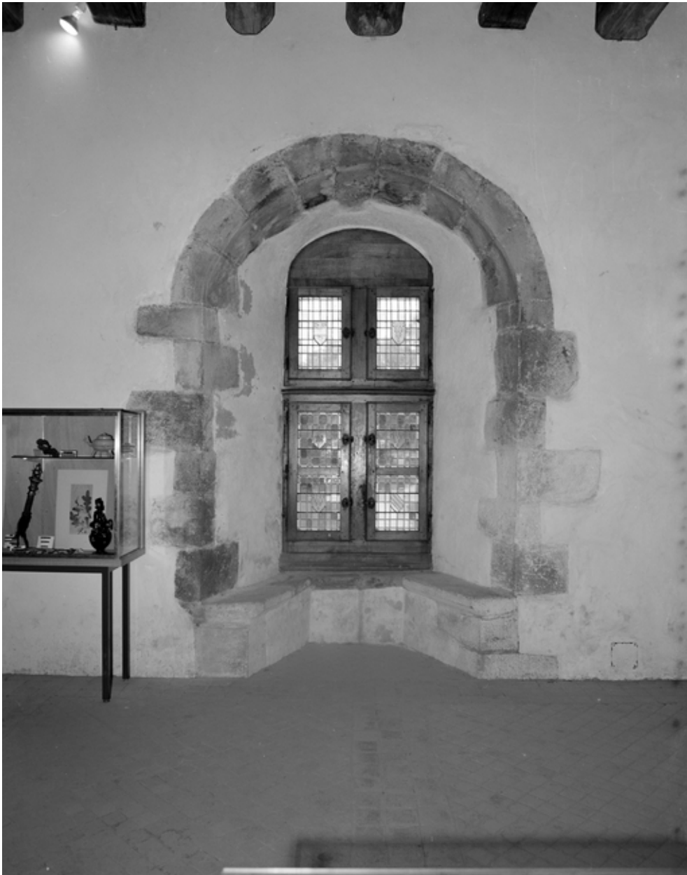
Vue de la grande salle au premier étage : détail de l'une des fenêtres à coussiège du mur gouttereau antérieur (état en 1974)
