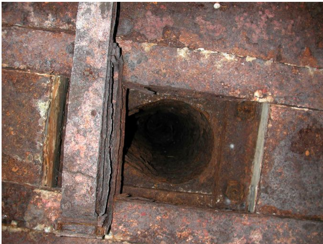
Vue de la casemate à toit blindé armée d'un canon de 75 mm Pak 40 (Type 626) (B 109) : orifice du périscopes
