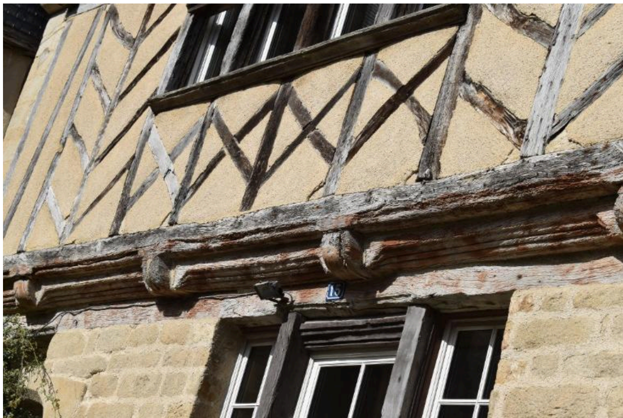
Détail des sablières d'encorbellement et des croix de Saint-André
