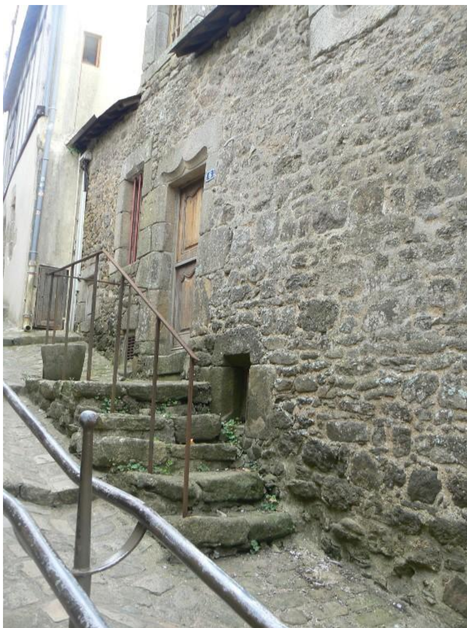
Escalier et porte secondaire donnant sur la rue Saint-René
