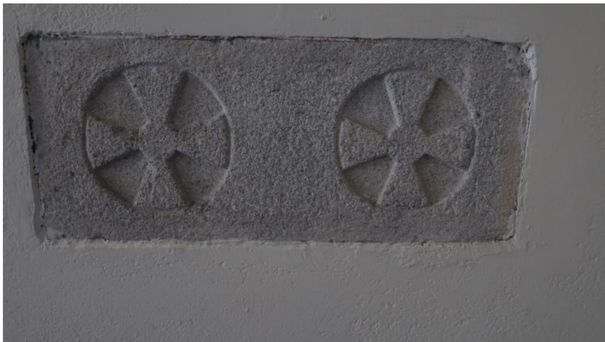
Chapelle transformée en CDI. Détail.
