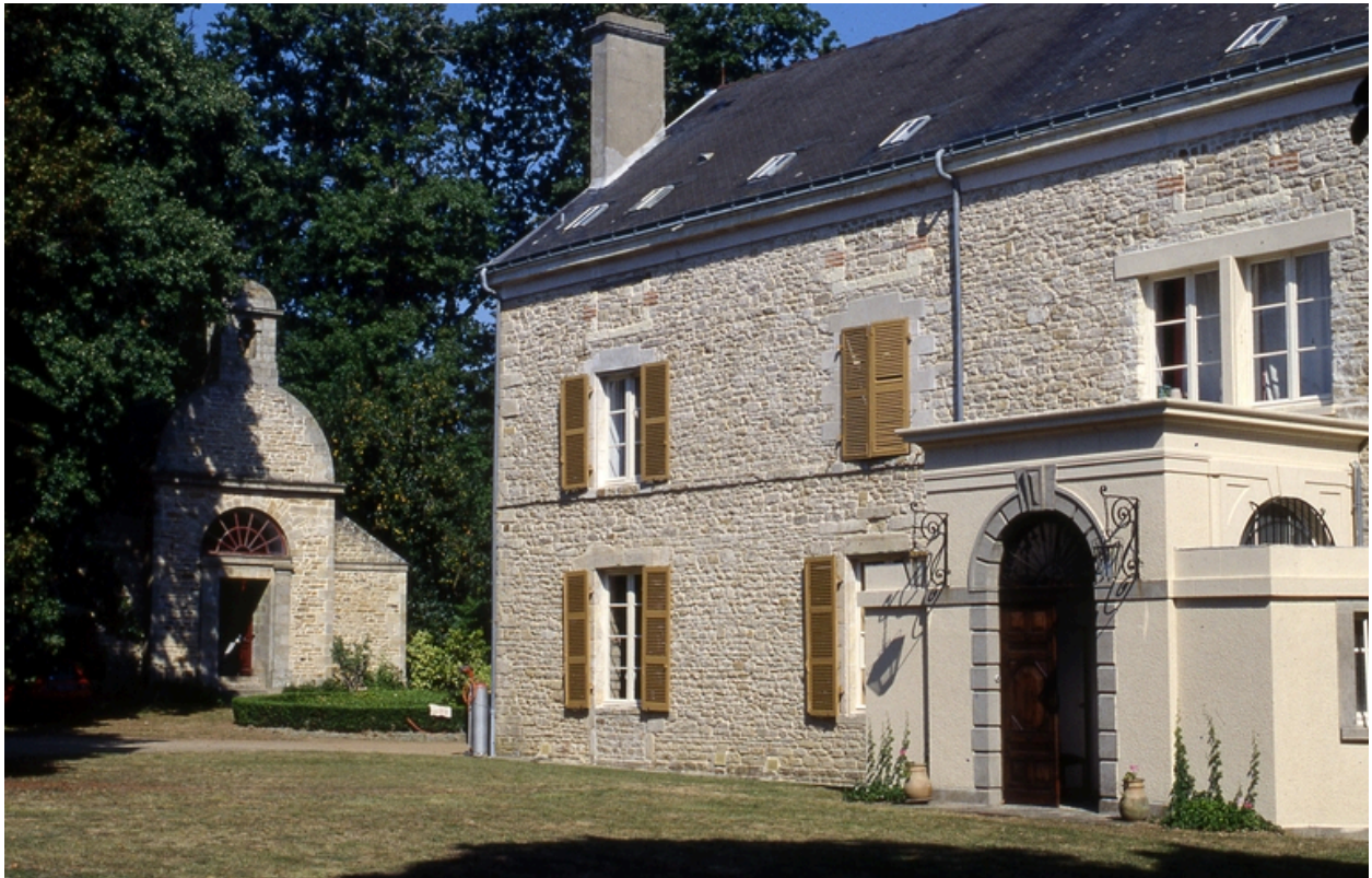
Elévation ouest, partie nord et chapelle
