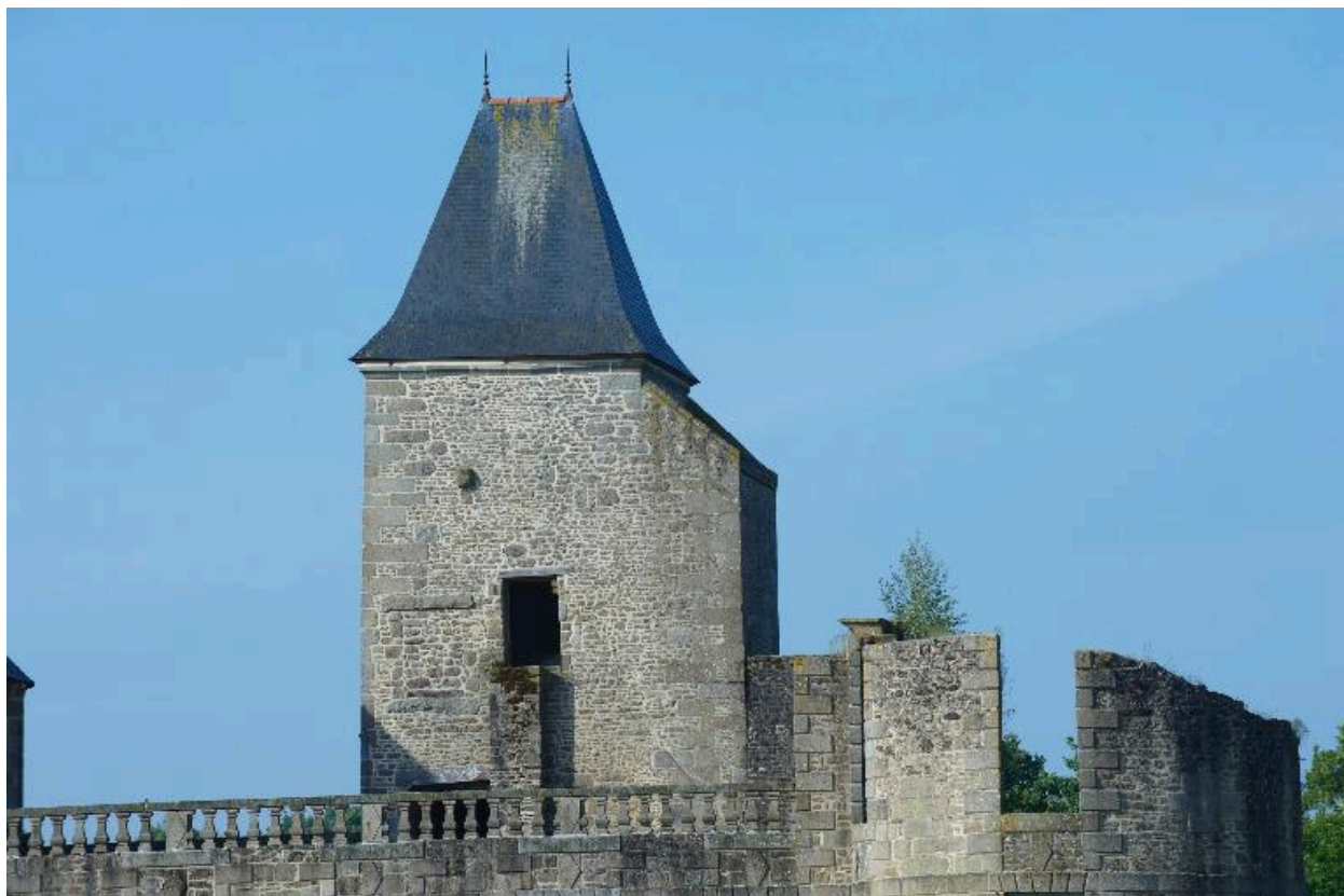
Détail de la tour d'escalier
