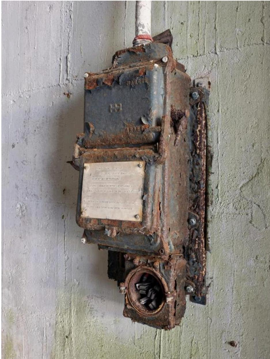
Vue du boîtier (fermé) de l'une des prises électriques triphasées du bassin D (tribord). Sur le boîtier : informations ("115 V 60 HZ 125 Amp - Bassin D - (tribord)") et consignes de sécurité
