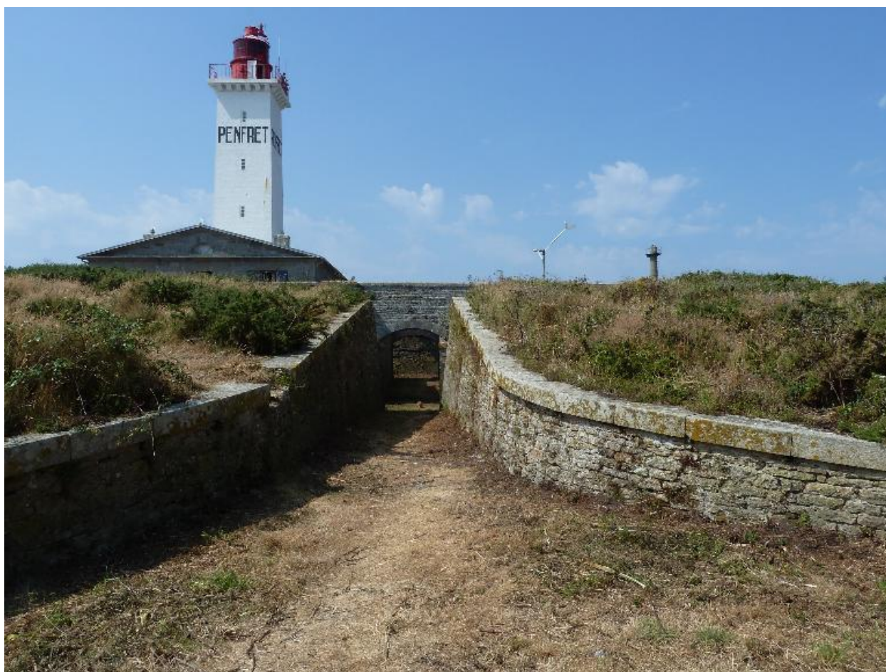
Archipel de Glénan, batterie de Penfret, tranchée de communication entre le fossé du réduit et la batterie.
