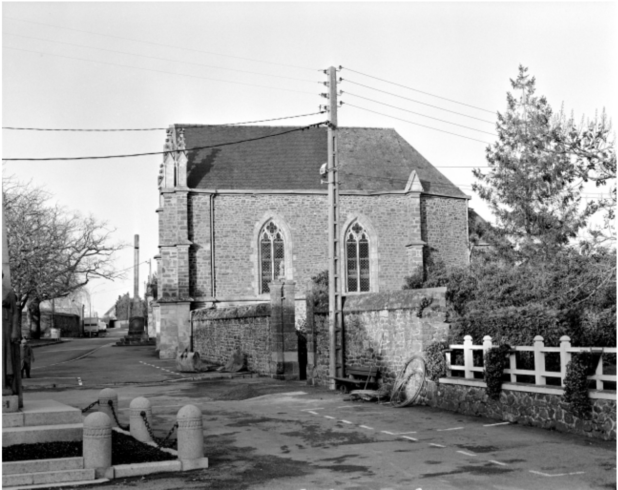
Elévation sud : vue générale
