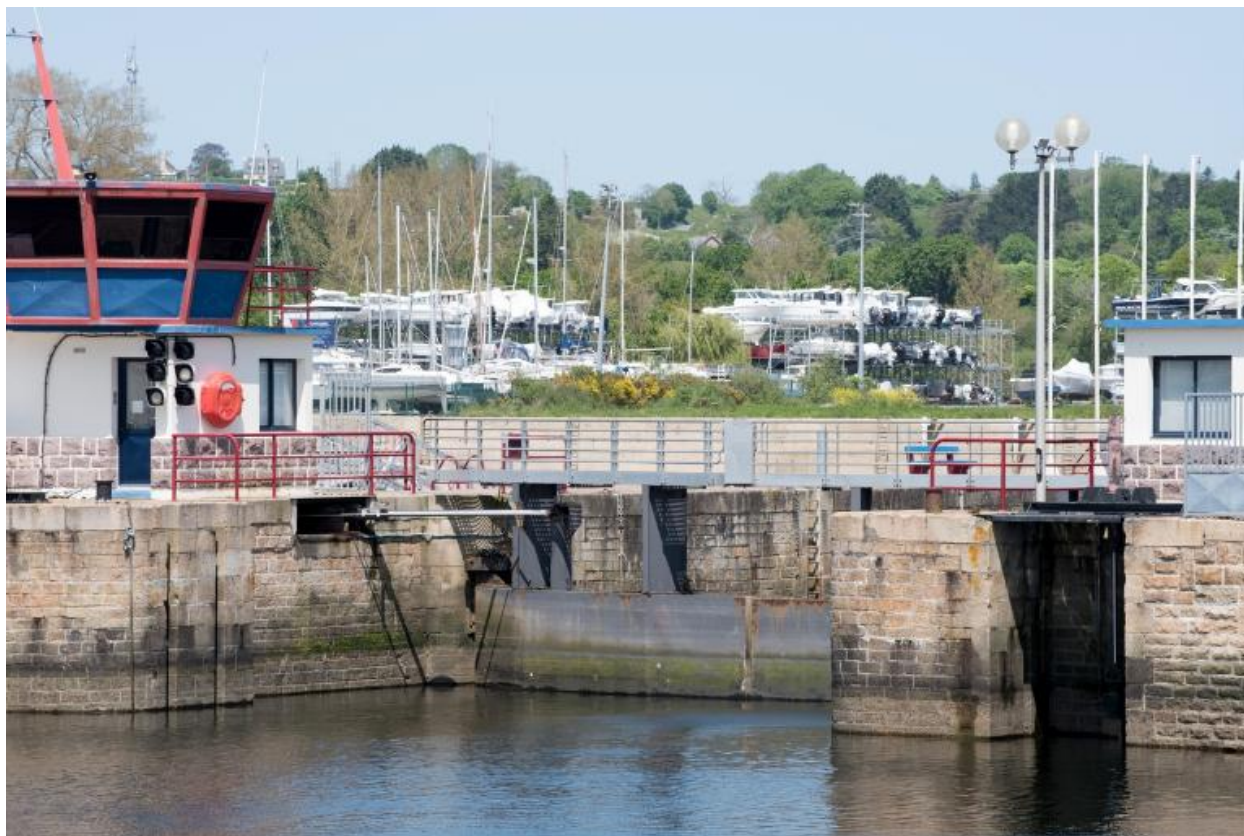
Ecluse du bassin à flot
