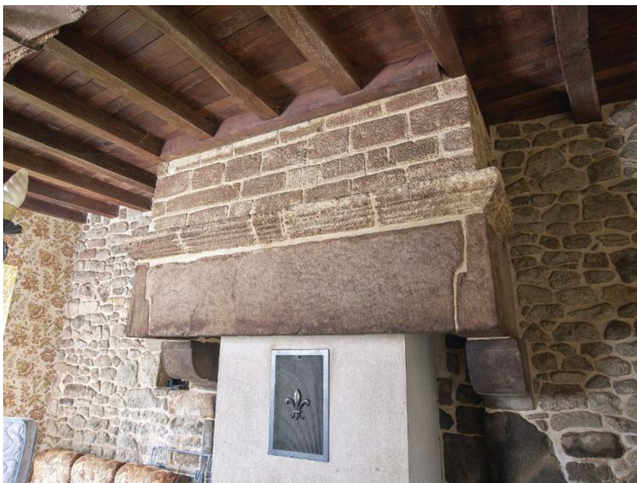
Salle du logis. Cheminée sur le pignon nord
