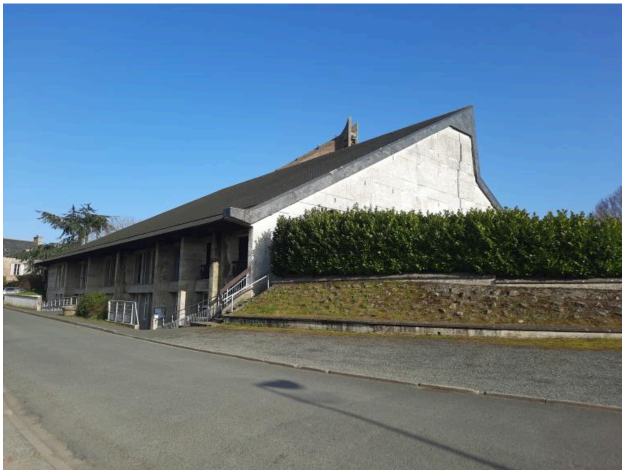
Vue d'ensemble côté ouest
