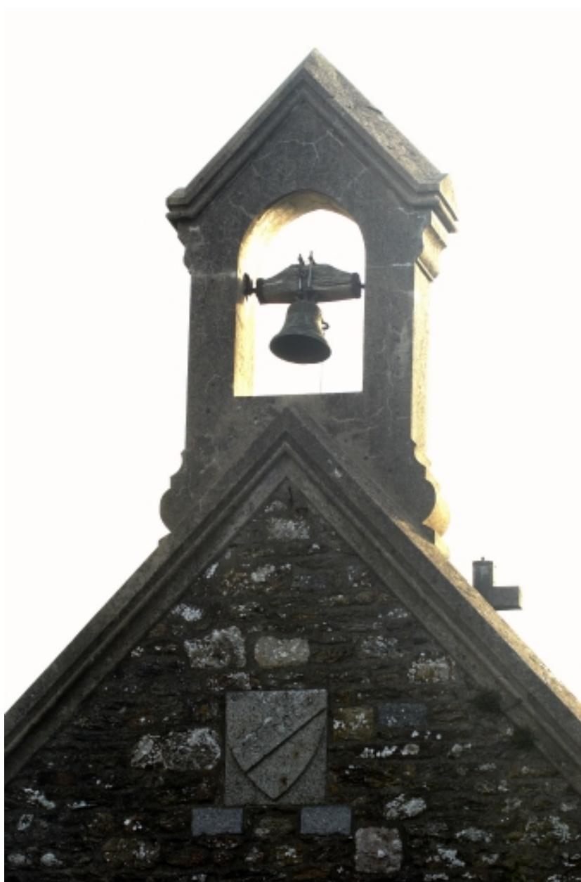
Elévation ouest : détail du clocher
