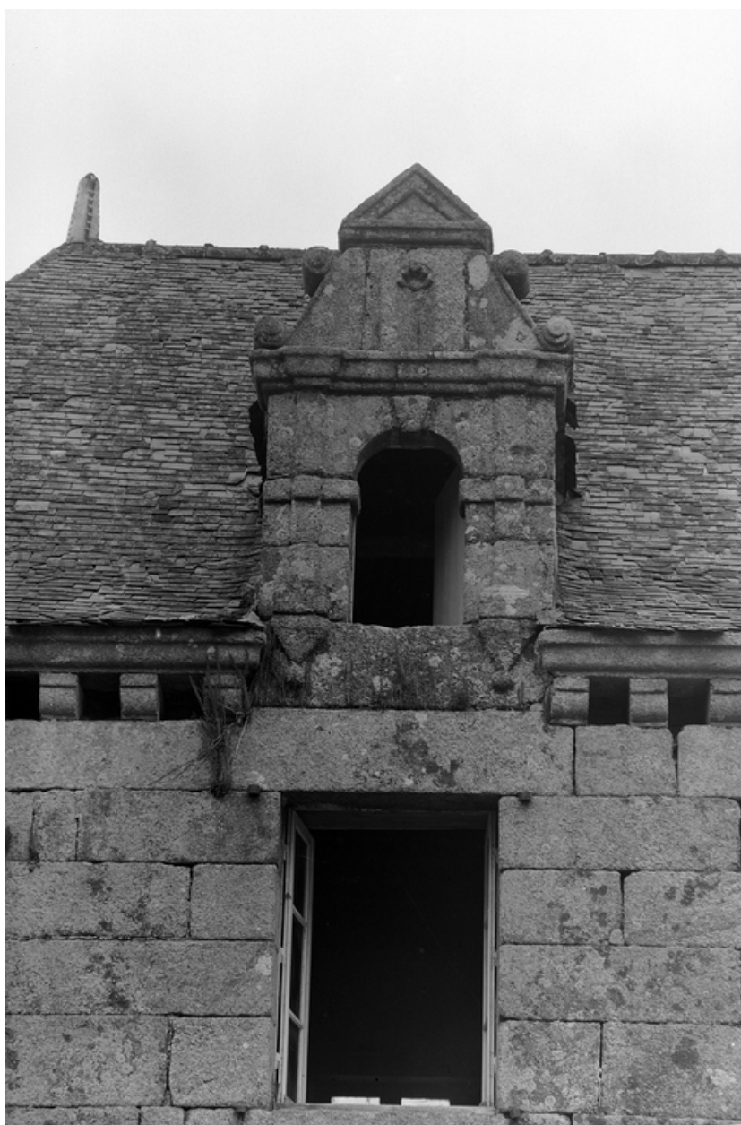
Façade sud : détail de la lucarne ouest
