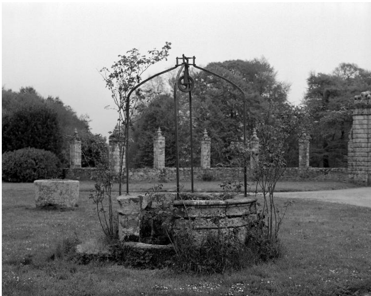
Puits, vue générale.
