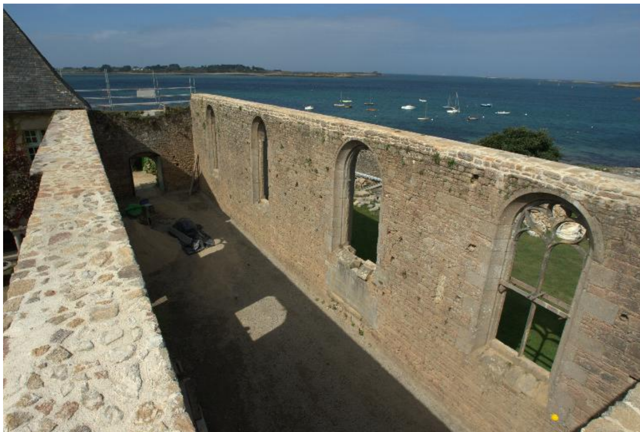
Vue intérieure de la nef de la chapelle
