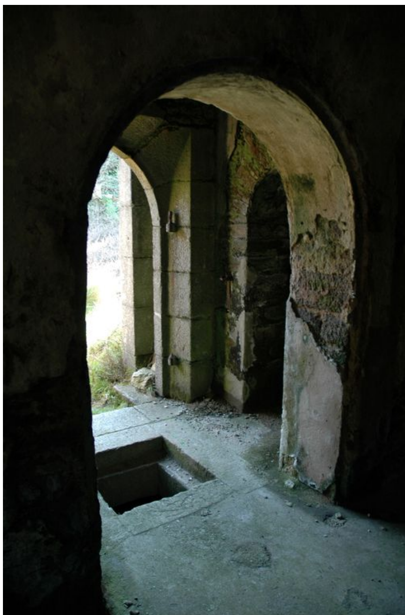
Vue intérieure : entrée (état en 2006). Au sol, regard de la citerne
