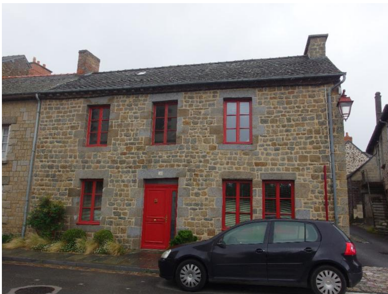
Vue de la façade ouest
