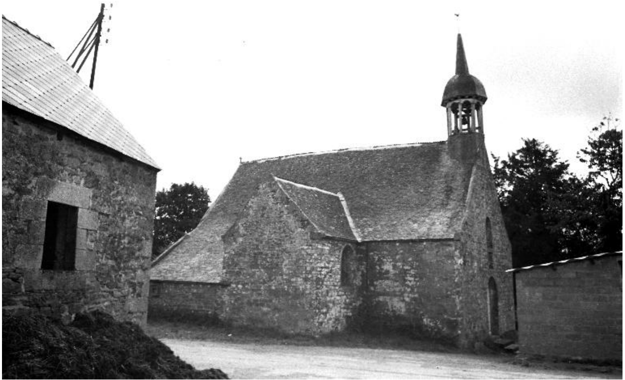
Vue de situation prise du nord.
