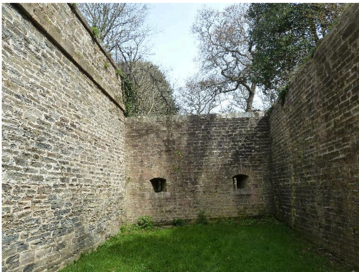
Le Palais, enceinte urbaine, bastion 20, mur crénelé de gauche.
