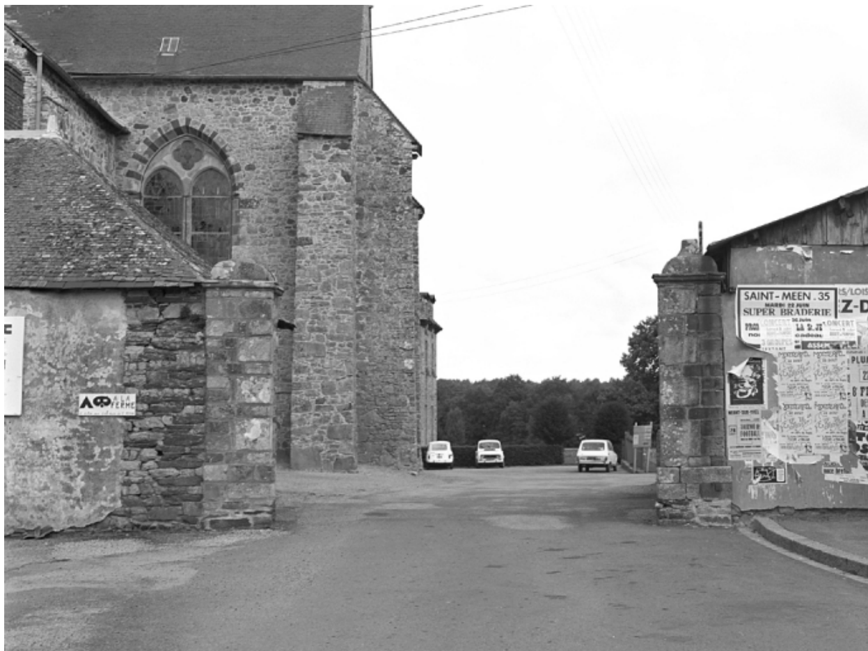
Eglise ; mur sud du choeur
