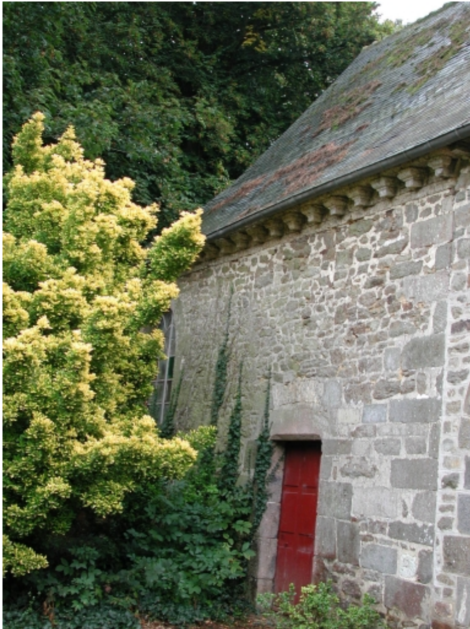
Chapelle : détail de l'élévation nord
