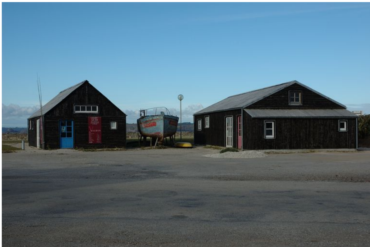
Vue des deux cabanes de la Tour Vauban
