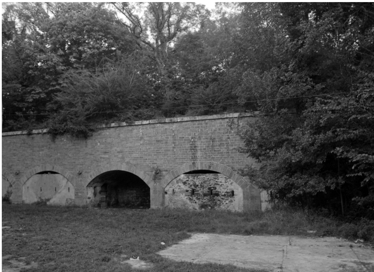
Enceinte de ville - Contrescarpe sur arceaux de décharge près de la porte Bangor, vue générale
