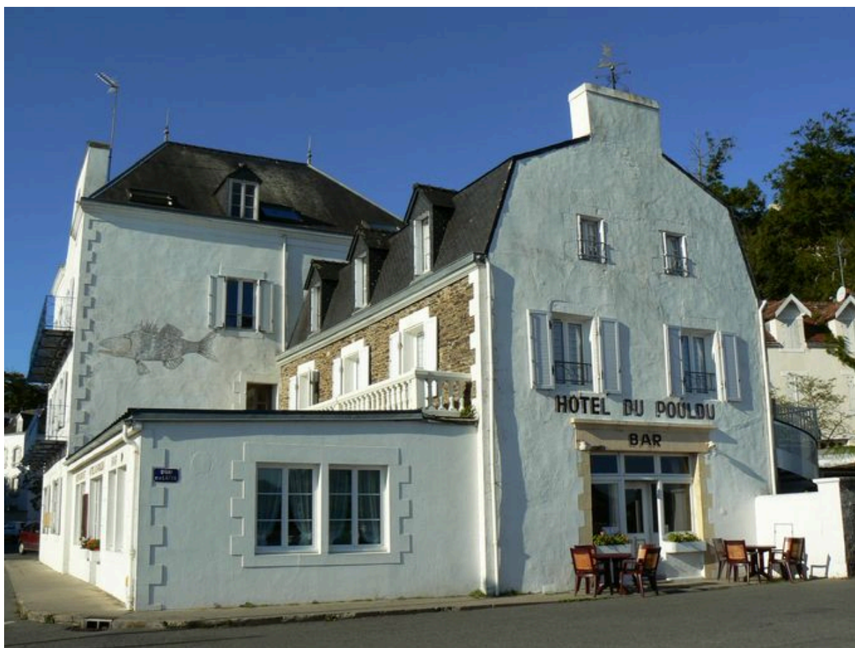
Façade nord-est de l'Hôtel du Pouldu
