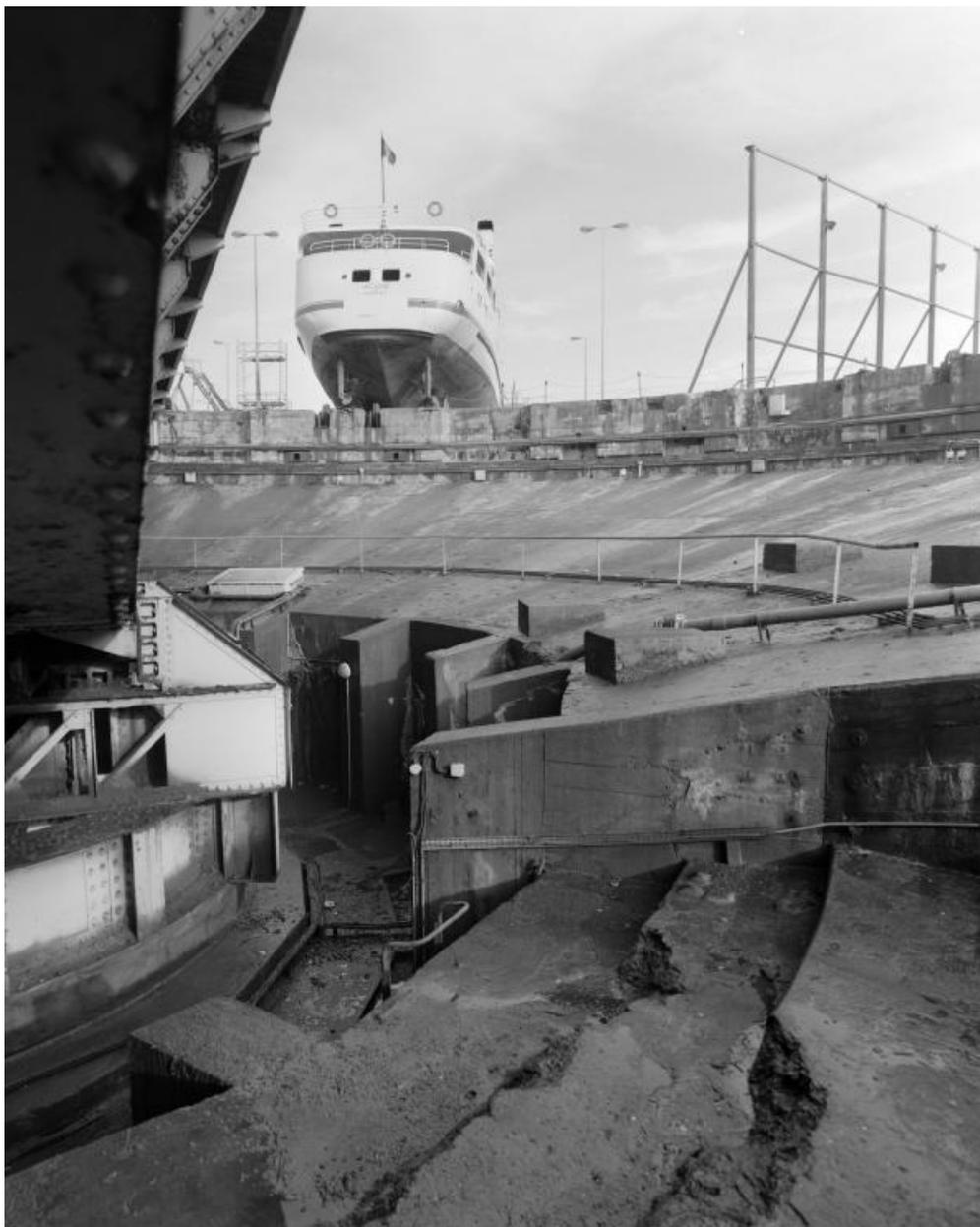
Vue de détail du pont basculant et tournant dans sa fosse bétonné en 2000 : axe central
