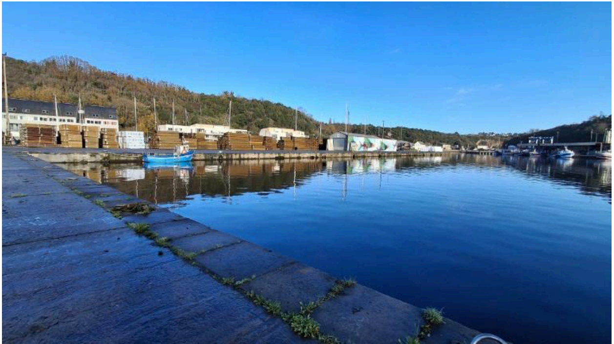
Vue générale du bassin Mézaubran
