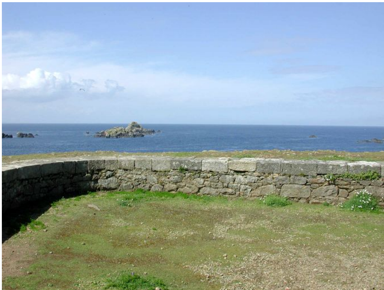
Vue du parapet de la batterie de la Théroute, en arrière plan : l'île-au-Cerf
