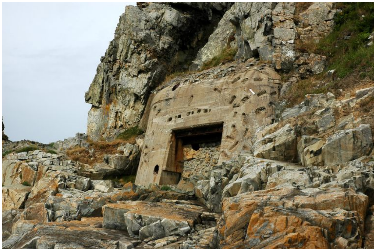
Perros-Guirec : casemate de type 669 intégrée dans la falaise
