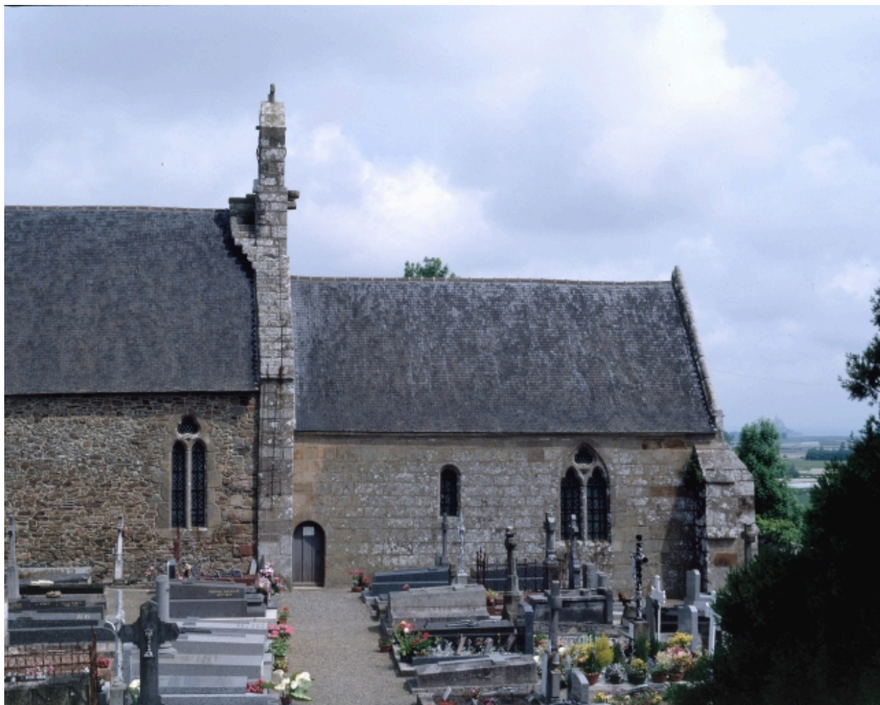
Elévation Sud : vue générale
