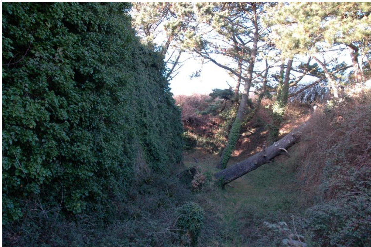
Vue de l'escarpe est et du fossé sec envahis par la végétation depuis la passerelle (état en 2006)
