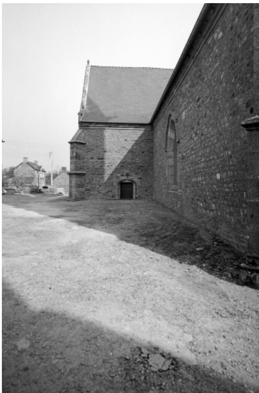
Façade nord, vue générale.
